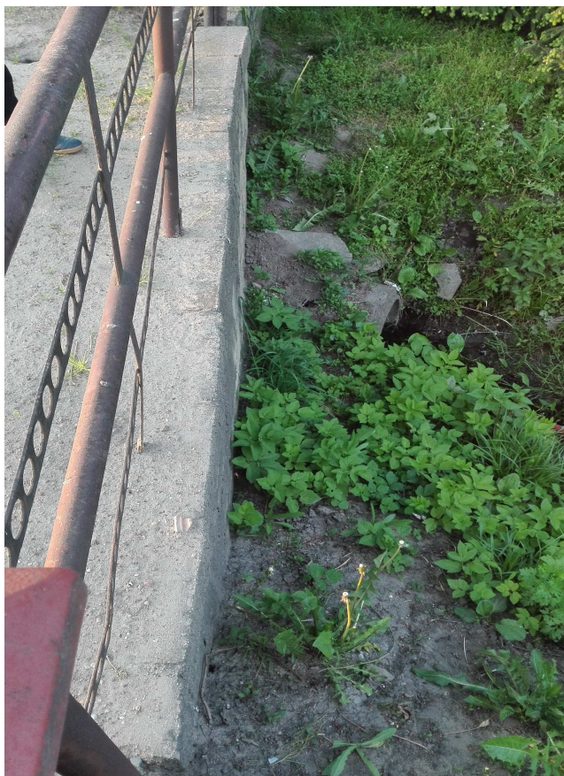
Fotografia 1. Widok od strony wlotu. Żelbetowa ściana czołowa przepustu,
