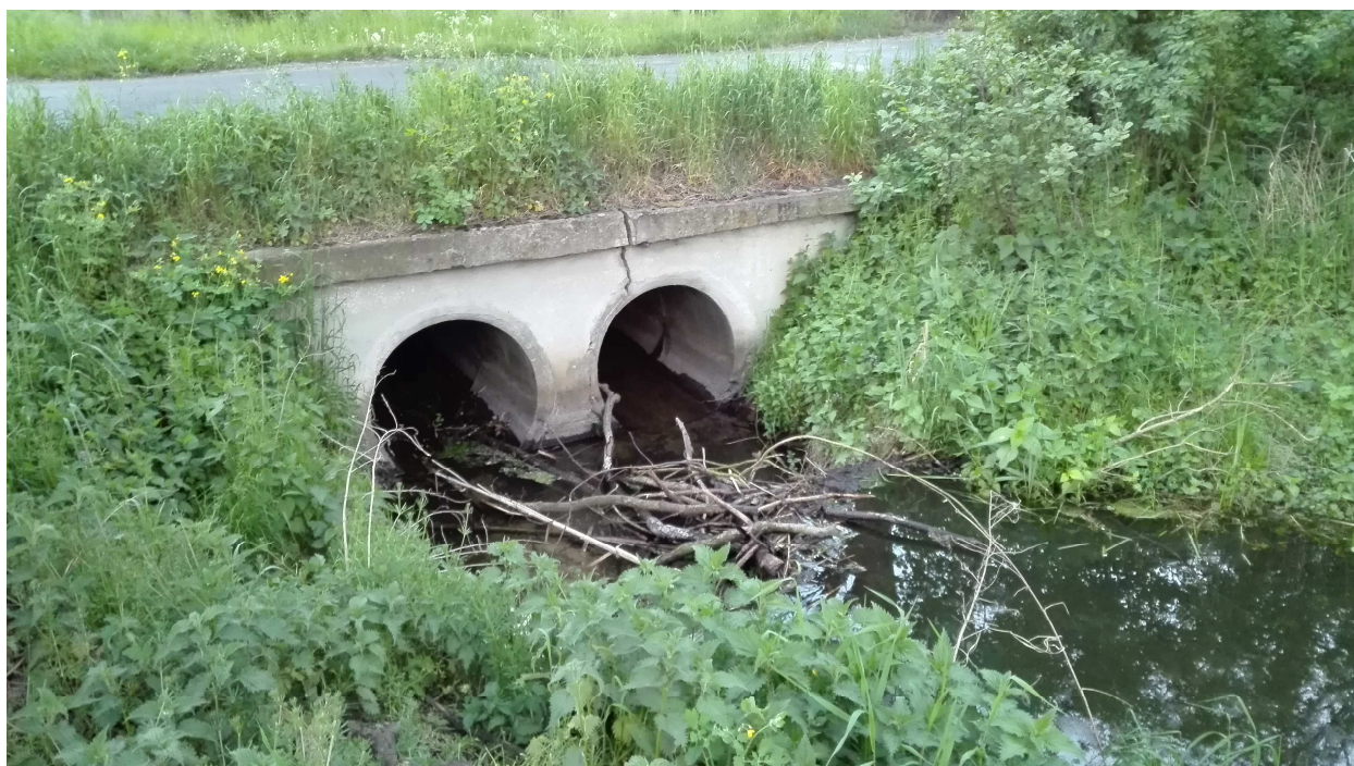
Fotografia 3. Widok od strony wlotu. Żelbetowa ściana czołowa przepustu, widoczne pęknięcie ściany czołowej
