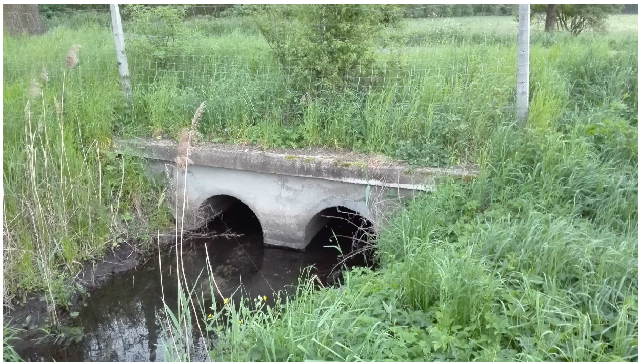
Fotografia 4. Widok od strony wlotu. Żelbetowa ściana czołowa przepustu,
